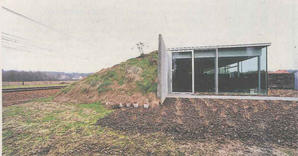
De noordgevel is ingegraven en vormt samen met het groendak een met gras begroeide wal. Die vormt een buffer tegen koude en tegen het geluid van de trein.
