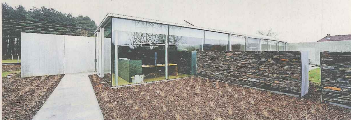
De glazen wanden, die niet geopend kunnen worden, werden 'koud' geplaatst. Zij kleven tegen de dakrand. Foto's Michel Wiegandt
